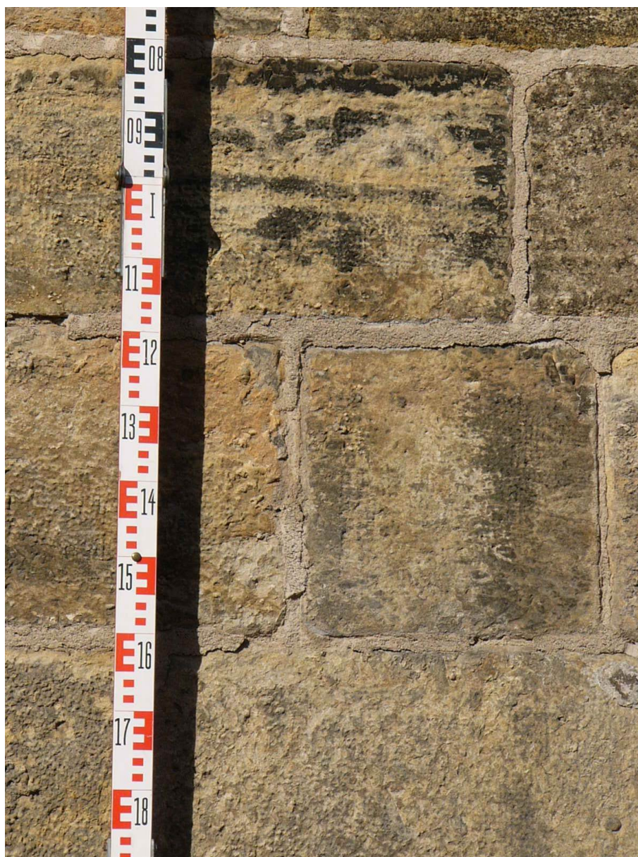
Obrázek 25: Zdivo poprsných zdí mezi pilíři č. 15 a č. 16, tzv. čelo č. 15
