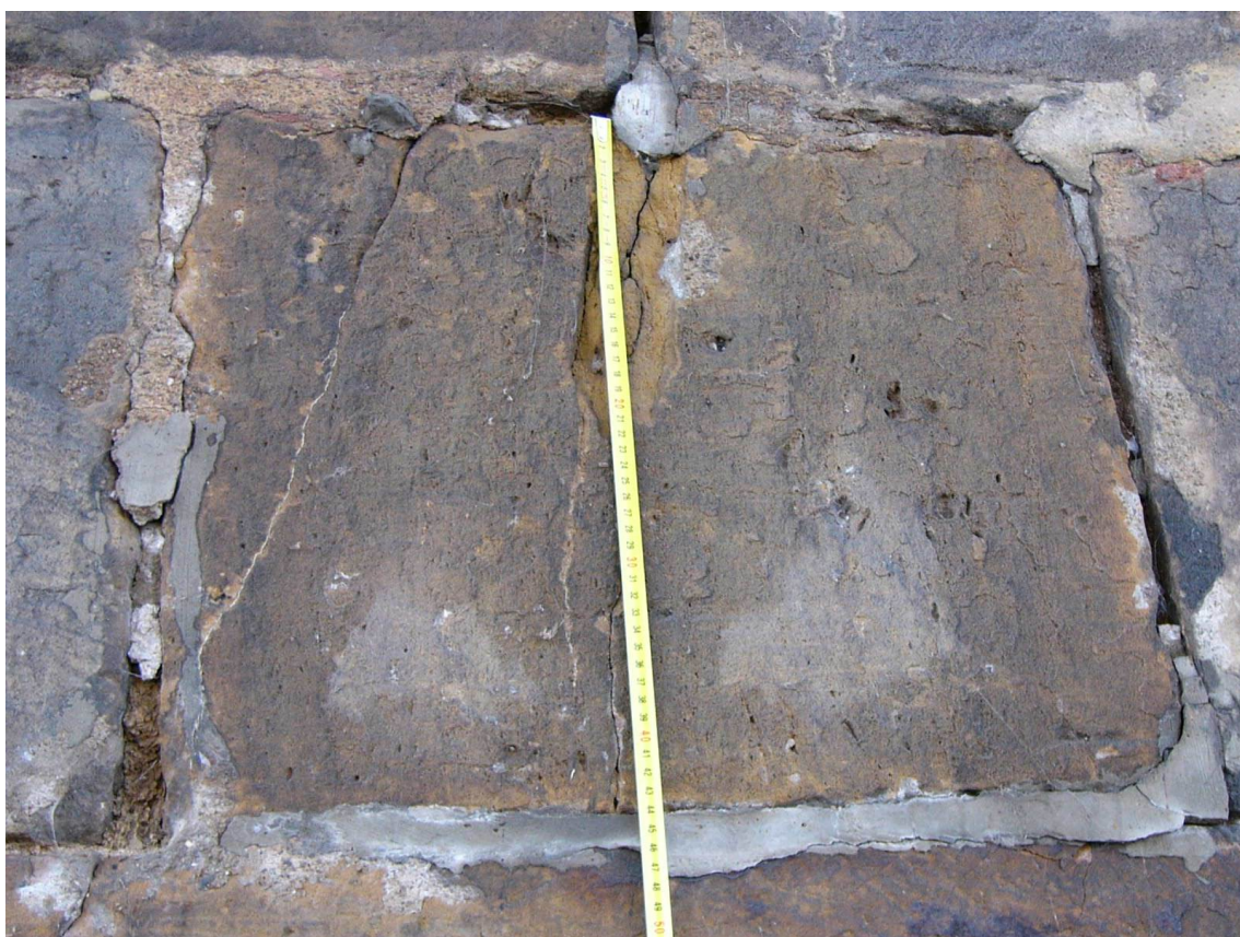
Obrázek 17: Detail trhliny
