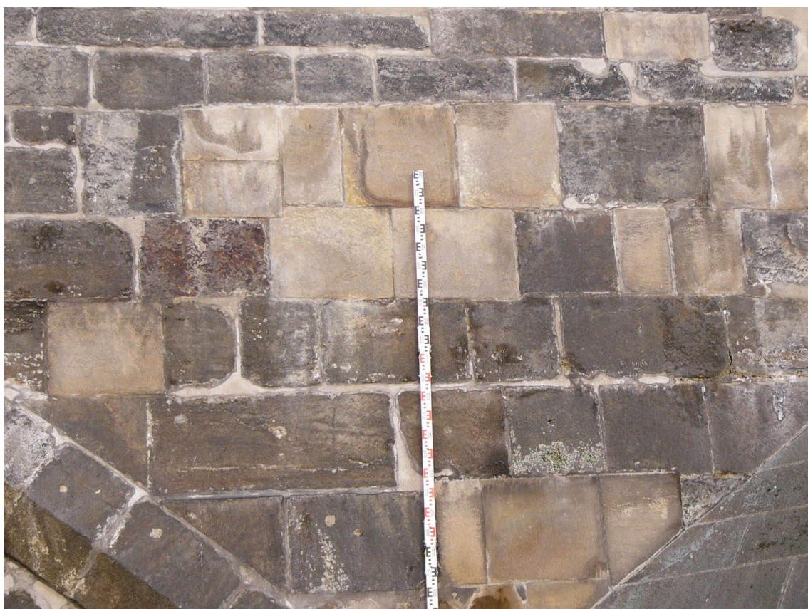
Obrázek 22: Zdivo poprsných zdí nad pilířem č. 15
